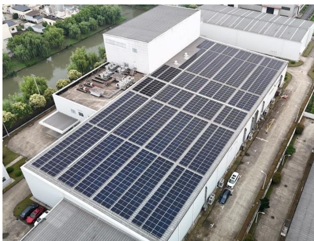
太陽光発電設備を導入した上海金山日粉食品有限公司
