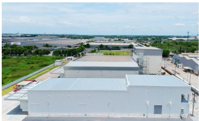
<手前の建物が今回竣工した冷凍生地製造工場>
