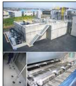
ニッポンエンジニアリング(株)が 施工した廃水処理設備プラント
