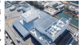
屋上設置の太陽光発電設備
