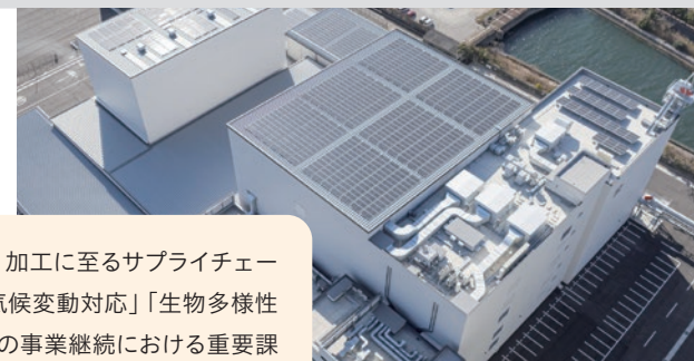
愛知県知多工場の太陽光発電設備
