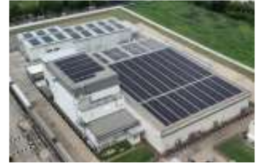
太陽光発電設備を導入した NIPPN (Thailand) CO.,Ltd
